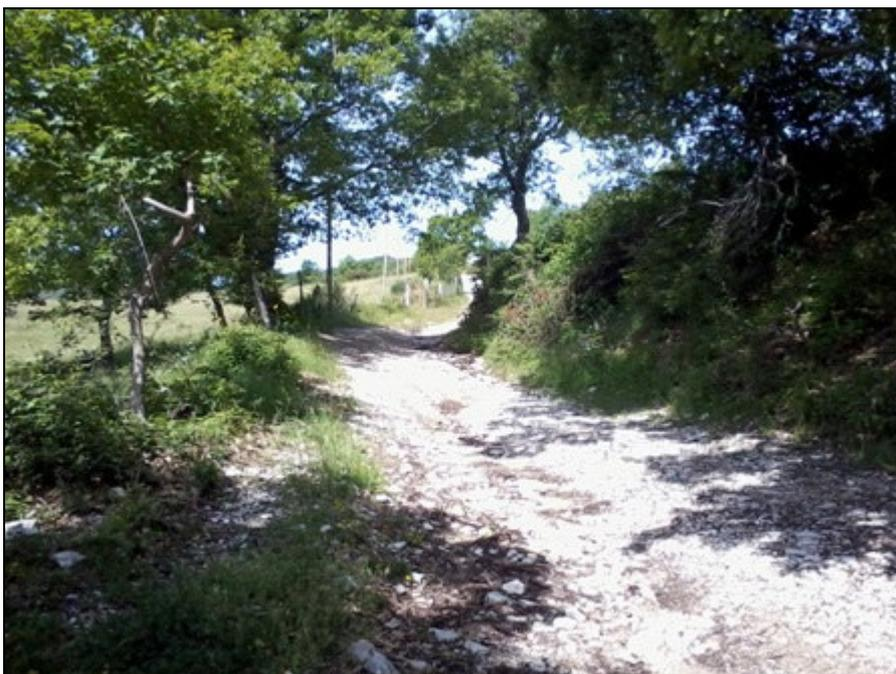
Strada camionabile classificata come viabilità principale, si nota l’erosione del piano viario che rende necessarie le opere di manutenzione.
